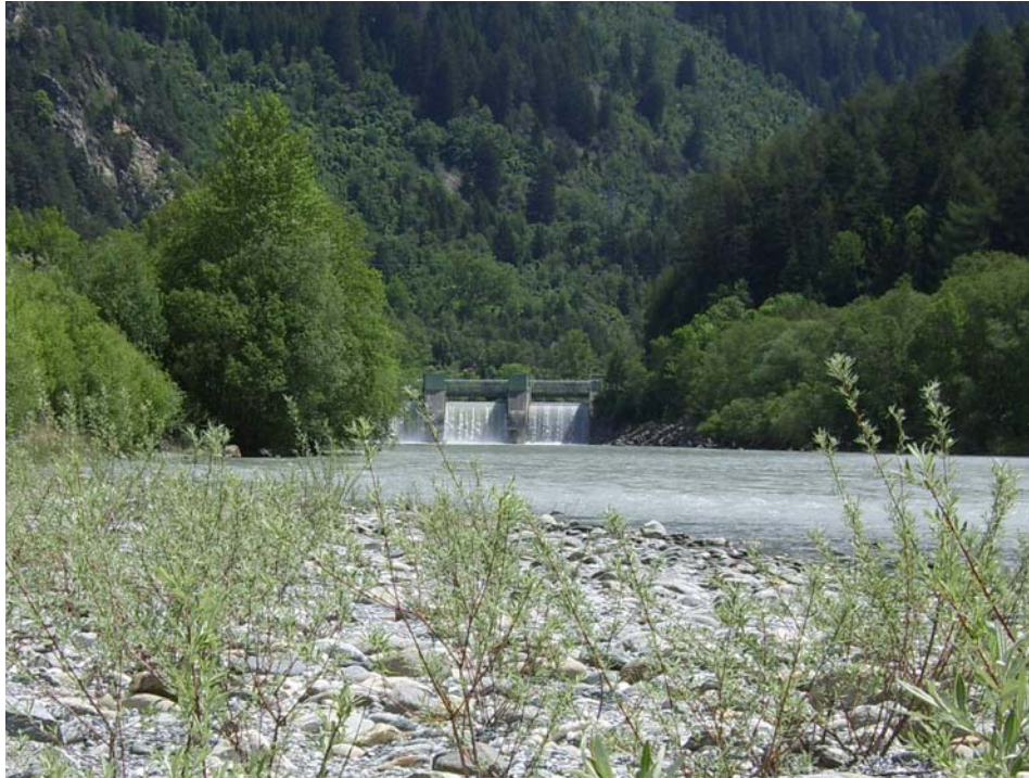
durch Schwallbetrieb beeinflusste Restwasserstrecke des Inn unterhalb des Stauwehres bei Altenzoll (flussaufwärts von Landeck), im Vordergrund junger Weidenaufwuchs (Juni 2007)
